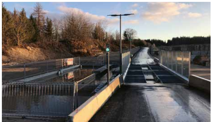
GRÜNES LICHT: Lkw, die den Steinbruch mit ihrer Ladung verlassen, gelangen dank der RWA 4 RU Stone sauber auf die Straße.
