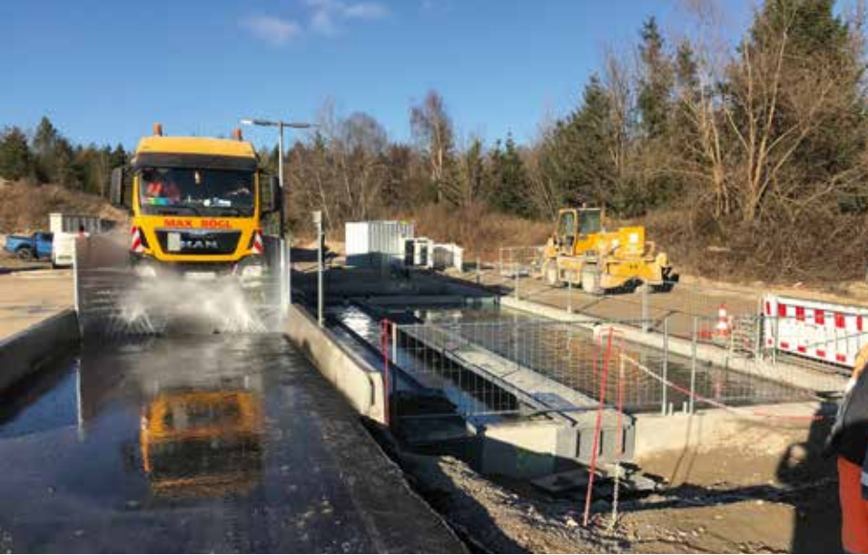
GEZIELTE ENTSCHEIDUNG: Die Reifenwaschanlage 4 RU an der Ausfahrt des Schotterwerkes Beilngries soll laut Hersteller die derzeit größte in Deutschland sein. Fotos: Wöhl
