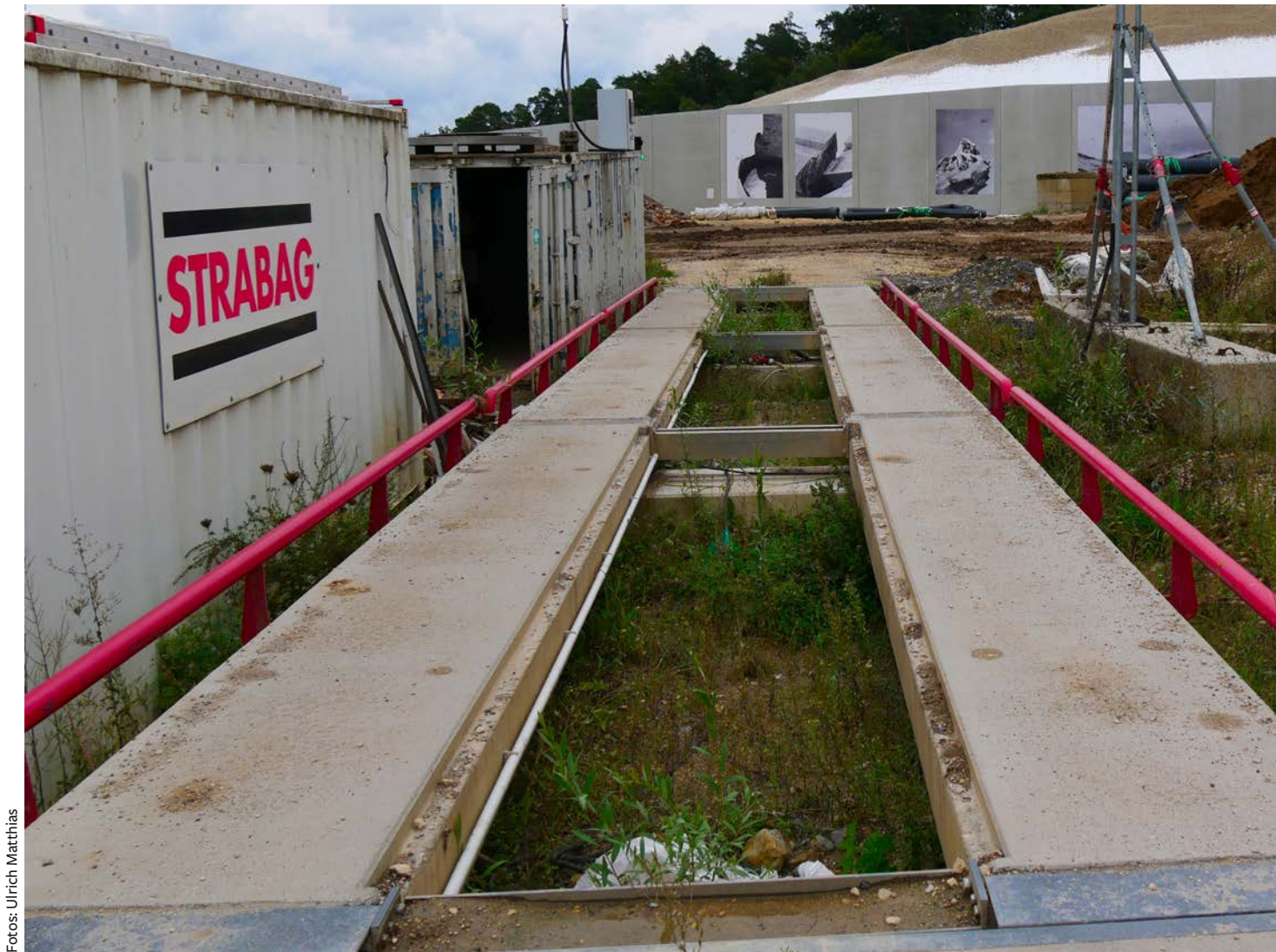
Die Lkw-Waage in Schorndorf benötigt kein Bedienpersonal. Im Hintergrund die schon mit Folie abgedeckte Deponie
